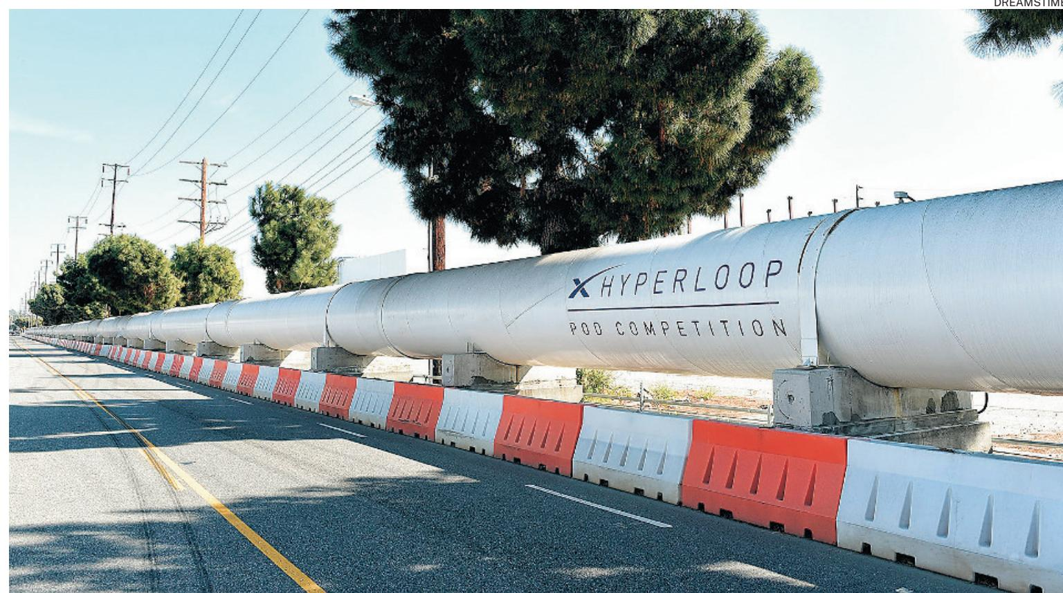
Tubo de pruebas de un sistema de transporte hyperloop
